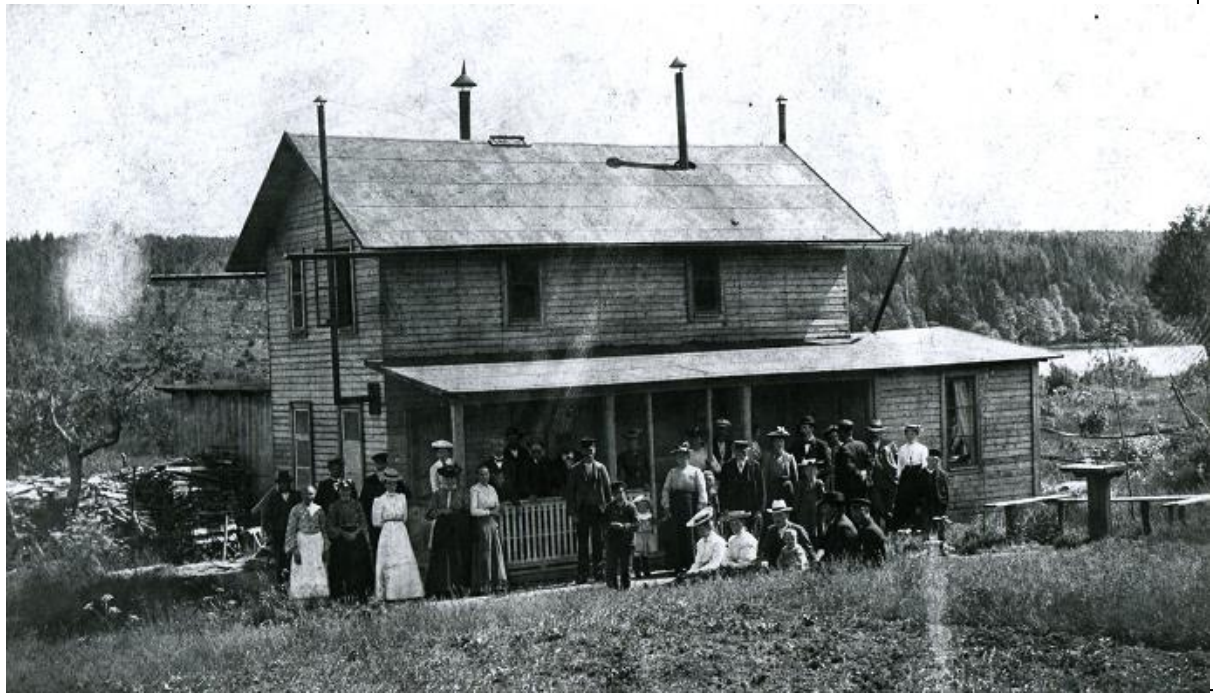
Badhuset, enligt uppgift omkring 1906-07. Huset hade då försetts med hängrännor och ytterligare ett ventilationsrör eller skorsten på taket. Obs, vedupplaget till vänster. Till höger syns ett bord med en kran där gästerna kunde fylla på källvatten i sina glas. Idag återstår av huset en grund om ca 8 x 4 m samt betongrester från badgolvet. Foto från Karlskoga Bergslags hembygdsförening.
