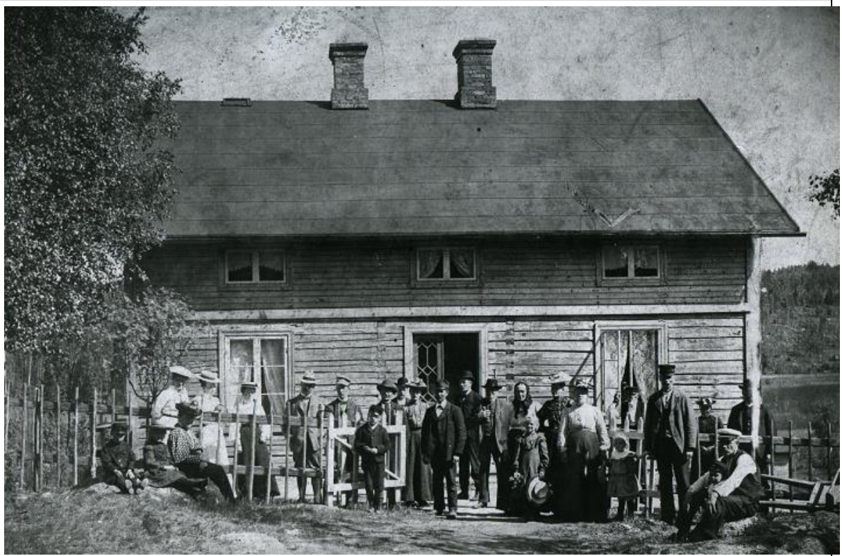
Hotellbyggnaden, här ännu inte brädbeklädd. Fotot är samtida med ovanstående foto, då det delvis är samma människor på bilderna. Byggnaden mätte ca 11 x 9 m. Bottenvåningen innehöll matsal och kök, på övre våningen fanns sex gästtrum. Källare fanns under huset. Huset ska ha flyttats till Kristinehamn när badinrättningen lades ner. Foto från Karlskoga Bergslags hembygdsförening.
