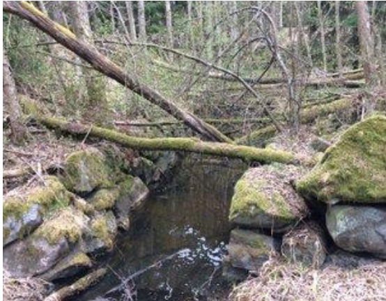
Den gediget byggda bassängen där vattenhjulet stått. Den är 10 m lång och 2½ meter bred. Höjden från botten till övre delen av stenarna är ca 1,5 m.
