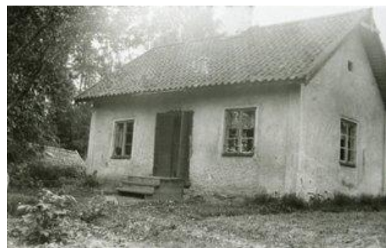
Torpet Kristersberg när det begav sig. Stugan mätte 8,5x5,5 m och boden 3,5 x 3,5 m. Såväl stugan som boden är uppförda i timmer, stugan dessutom rappad, men båda är nu nära nog fullständigt raserade. Torphuset uppfördes förmodligen 1805. Intill stugan finns en bastant byggd jordkällare. Det lär även ha funnits en smedja på platsen.
