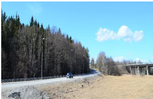
Området vid Broängsbacken idag. Vägbanken ligger högt över den äldre vägen.
