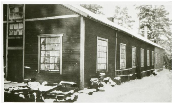
Gjuteriet. Närmast i bild låg kärnmakeriet och längst bort var efterbehandlingen i rensboden där det även fanns ett litet kontor. I det stora utrymmet däremellan arbetade gjutarna med gjutformar och flaskor. Golv sänkades i gjuteriet och backen var täckt med sand för att minska brandrisken. Foto från kommunens bildarkiv.
